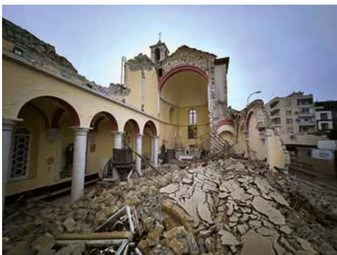
Die am 6. Februar fast vollständig zerstörte katholische Kathedrale von Iskenderun.
